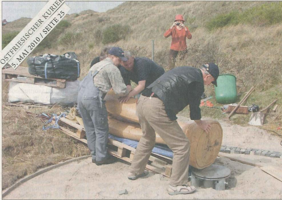
Auf dem Fundament aus drei Krinnerschraubelementen und einer drehbaren Spezialkonstruktion wird die Windharfe errichtet und befestigt.
